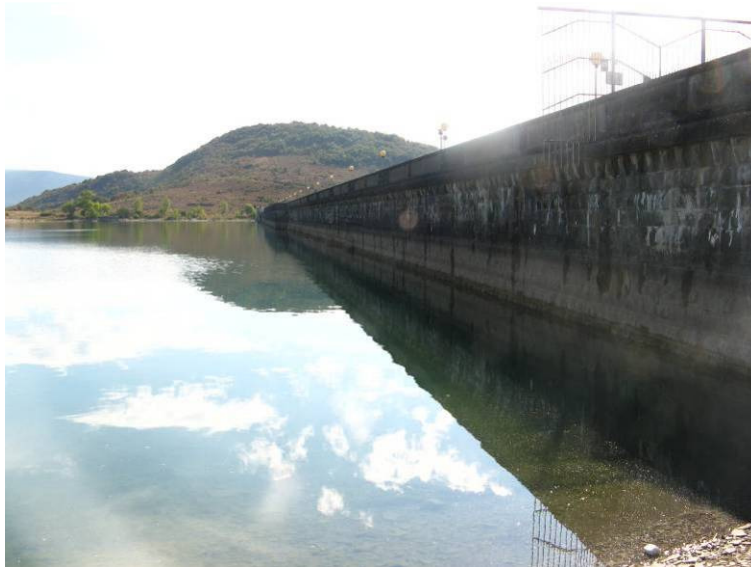
Figura 3. Embalse de Ullibarri-Gamboa. Presa
