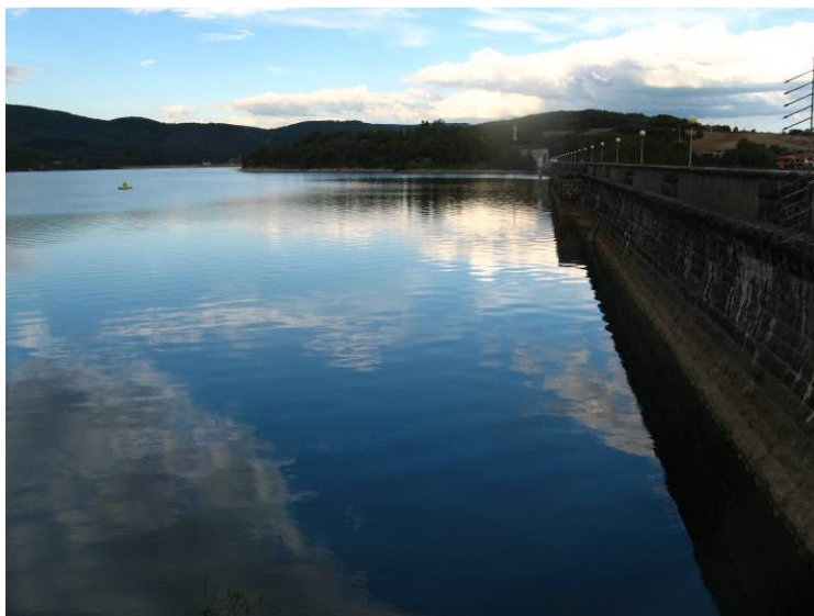
Figura 5. Embalse de Urrunaga. Presa
